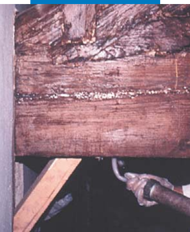
Iniezione di Mapewood Gel 120
