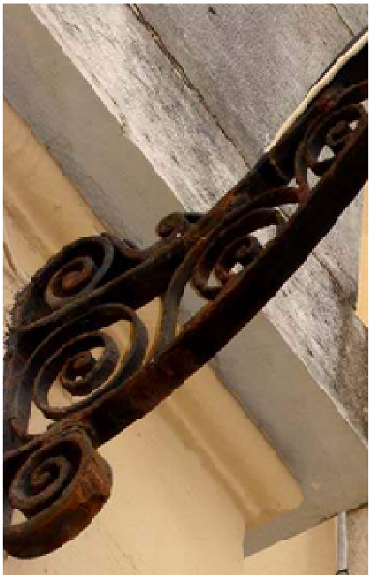
Oxidació del ferro i pèrdua de material
