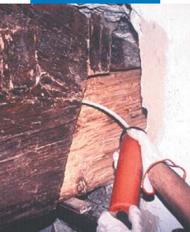
Iniezione di Mapewood Gel 120
