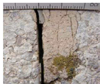
Presència biològica en diversos elements de les façanes
