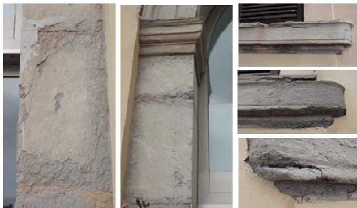
Proves de neteja mecànica
