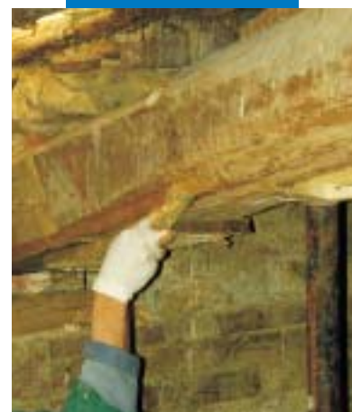
Applicazione di Mapewood Paste 140
