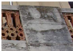
Presència biològica en diversos elements de les façanes
