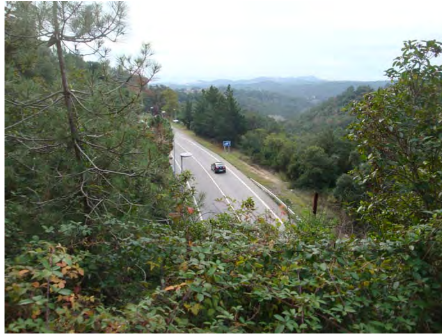
Carretera C-63 des del carrer de la Garrotxa (sobre el túnel Monturiol)
