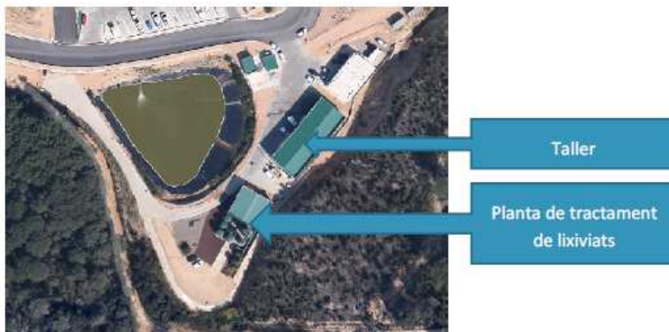
Planta de tractament de lixiviats existent i taller
