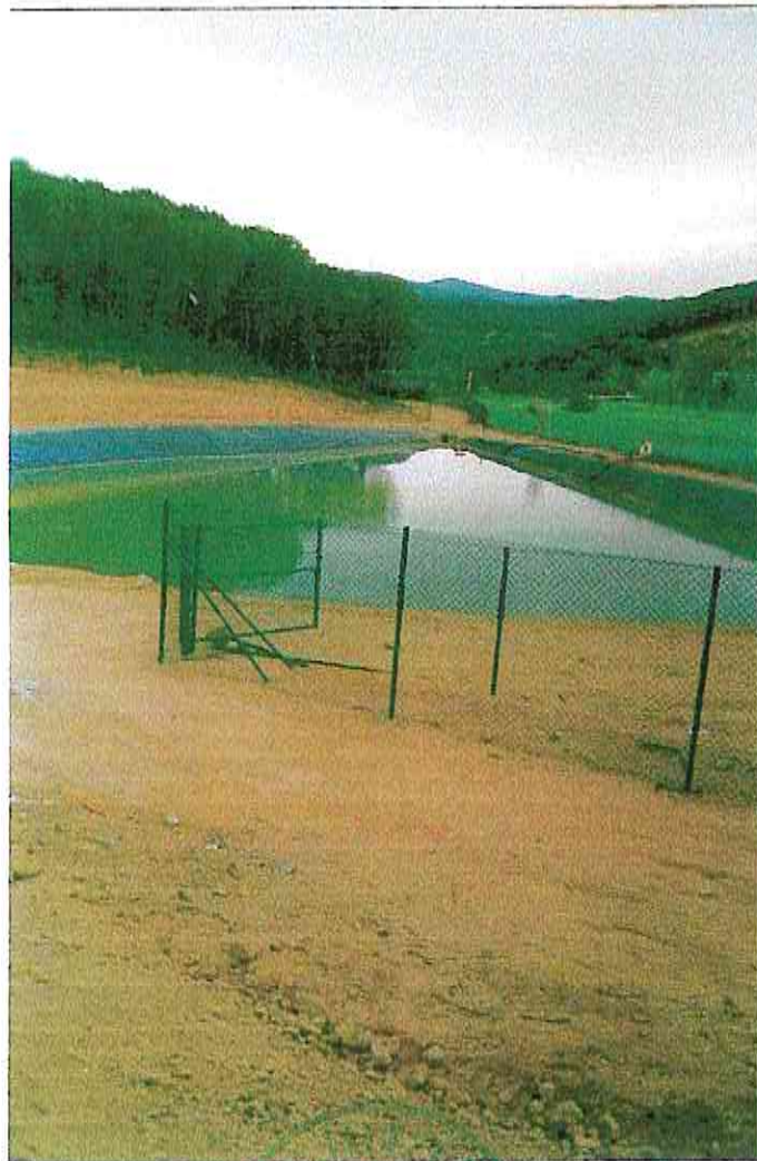
BALSA DE AGUA DE SALIDA DEL VERTEDERO LLORET DE MAR
