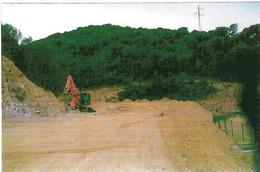
EXPLANACION DE TERRENO PARA LA PLANTA DE LIXIVIADOS - LLORET DE MAR
